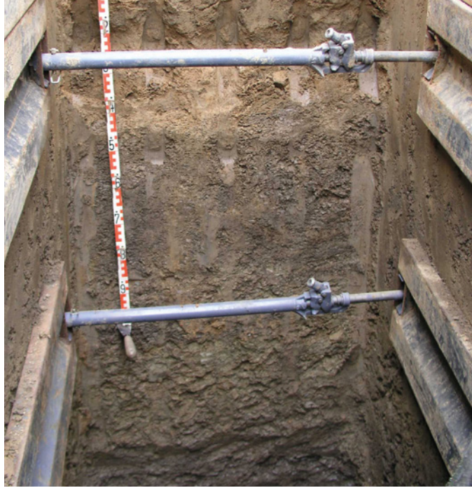
Schürfgrube zur Beurteilung der Bestattungseignung
