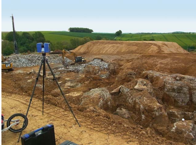
Das Laserscan-Gerät auf der Baustelle der Autobahn A 44 bei Heiligenhaus
