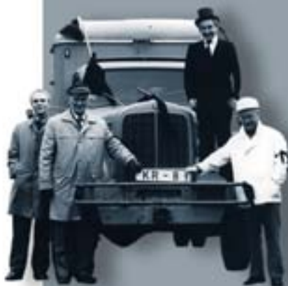
Ob gestern oder heute: Bohrwagen sind unentbehrliche Helfer bei der Datenerhebung im Gelände.
