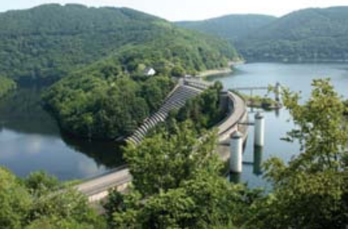
Staumauer der Urfttalsperre in der Nordeifel
