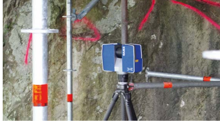
Mittels Laserscanner wird die Felswand zur Planung weiterer Sanierungsarbeiten vermessen.
