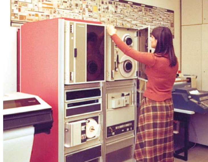
Späte 1970er: Einlegen der damals als Daten- und Programmspeicher verwendeten 1-Zoll-Magnetbänder. Im Hintergrund eine „Teletype“ (Fernschreiber), die als Kommandokonsole und Lochstreifenlesegerät diente.
