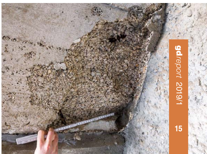
Kiesnest an der Unterseite eines Gurtbalkens
