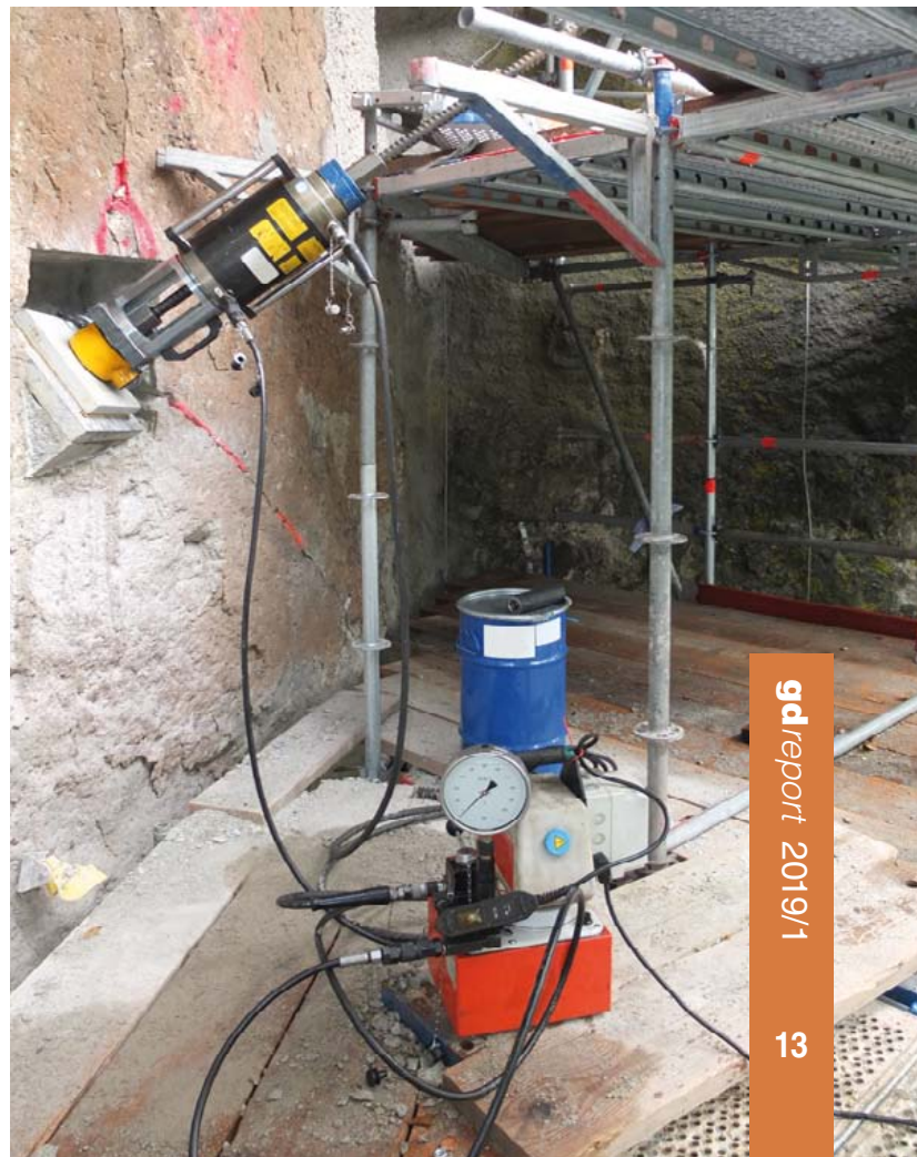
Einbau eines Spanngliedes
