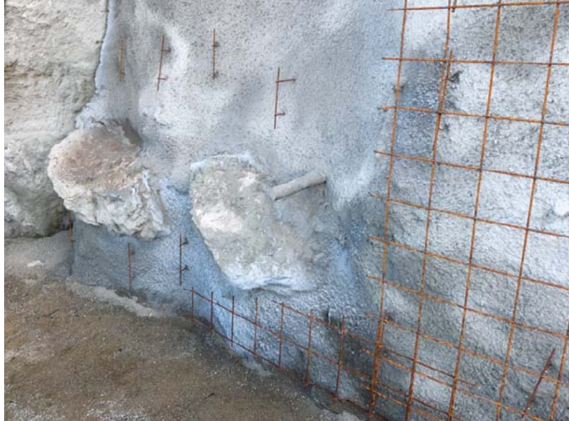
Spritzbeton mit Bewehrung
