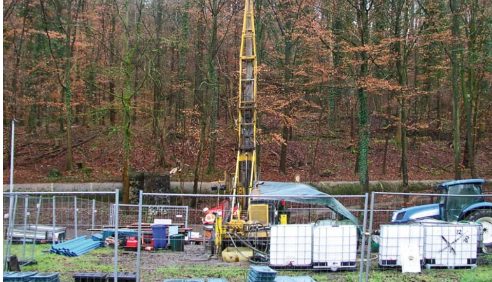
DGE-ROLLOUT- Bohrung in Heiligen- haus, Januar 2020
