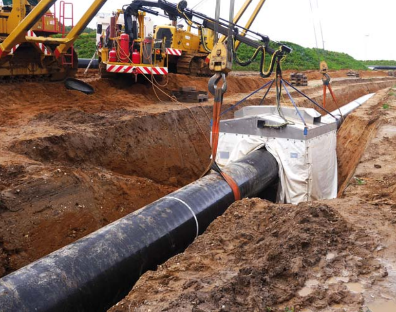
Pipelinegraben mit Schweißgrube
